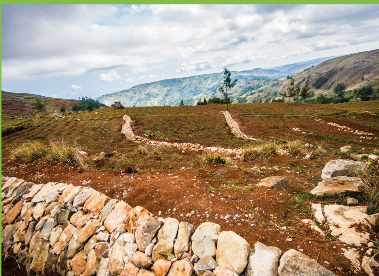
Stone constructions between fields are protecting the soil from eroding. // Des constructions en pierre entre les champs, protège la terre d'érosion.
