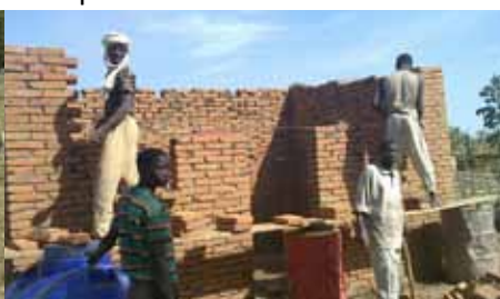
Amélioration des abris pour les personnes vulnérables dans les villages d'origines des PDI
