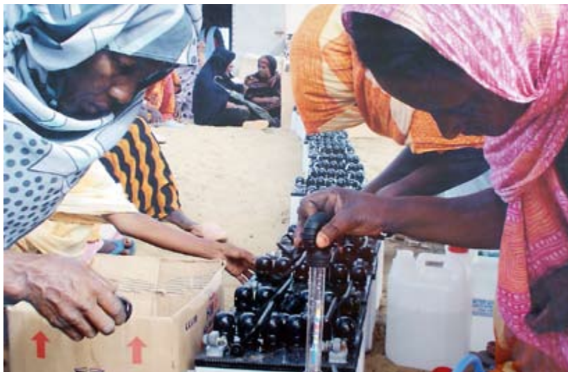
Die Solartechnikerinnen Salka Meissara (li.) und Bowba Ibrahim (re.) installieren im Südwesten Mauretaniens eine Solarzelle. © LWB/AWD-Mauretanien
